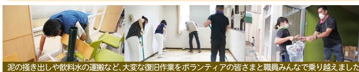
泥の掻き出しや飲料水の運搬など、大変な復旧作業をボランティアの皆さまと職員みんなで乗り越えました。
